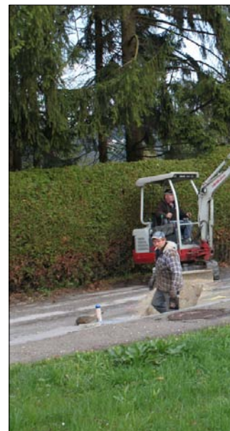
Die Sanierungsarbeiten der SchulstraÙe
