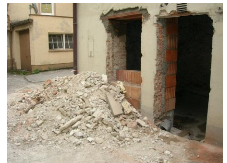
Aufmauern eines Fensters beim Müllraum
