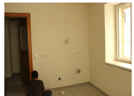
Installationsarbeiten im ehem. Trafikraum
