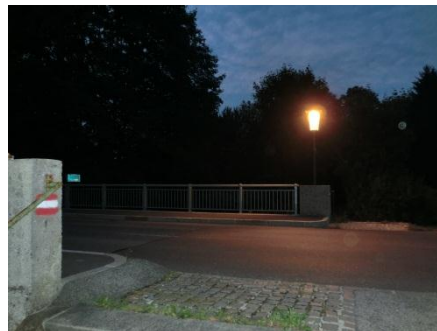
Neue Straßenbeleuchtung bei der B22, Foto R. Böcksteiner
