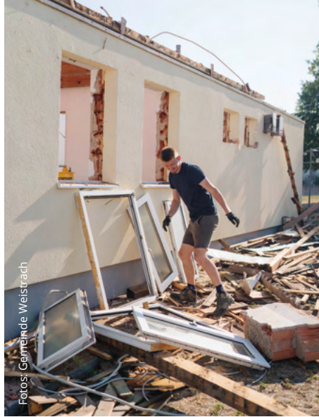
Tatkräftiger Einsatz beim Start der Bauarbeiten: Mit den Abbrucharbeiten hat die Umsetzung des neuen Sporthauses offiziell begonnen.
