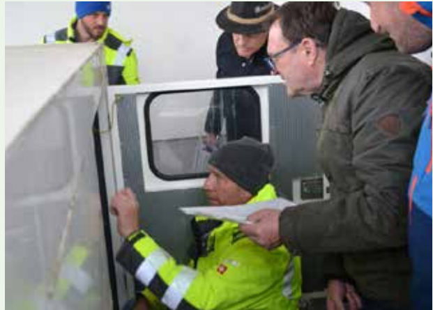
Inbetriebnahme des Notstromaggregates
