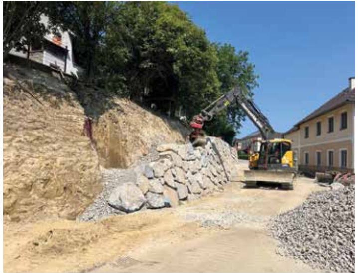
Die Steinwurfmauer in der Haabergstraße nimmt bereits Form an.
