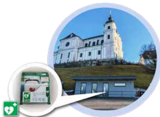
Ortsteil Sonntagberg – Öffentliches WC Parkplatz unterhalb Basilika
