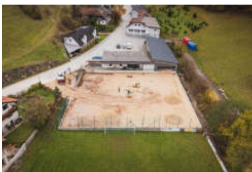
Der Neubau der Tennisanlage schreitet voran.
