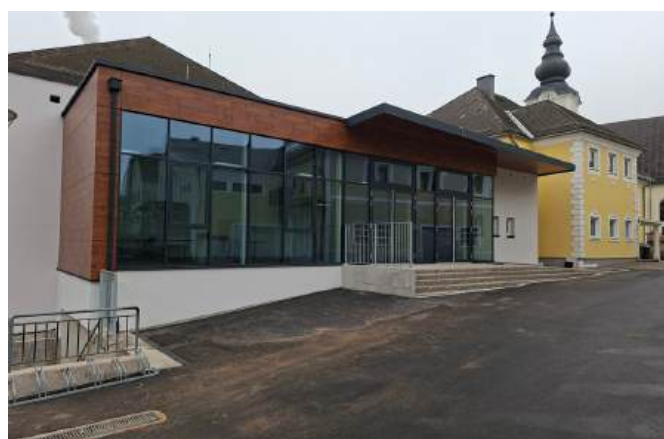
Der fertiggestellte Zubau
