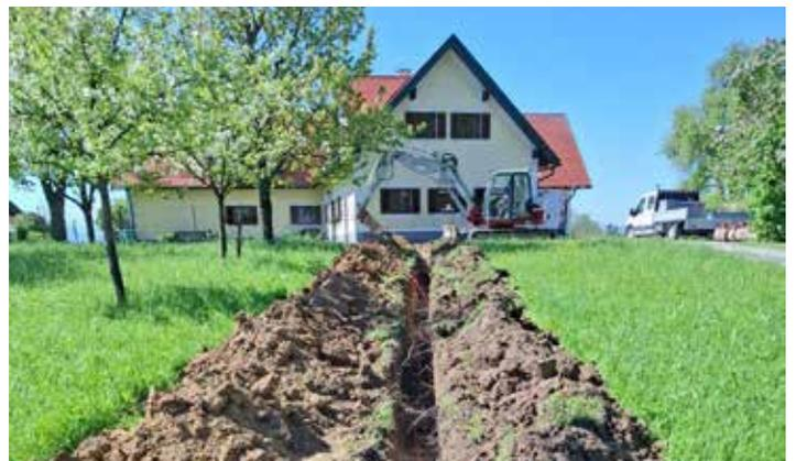
Bei diesen Grabungsarbeiten wurde auch schon der Hauptstrang für die Ortswasserleitung nach Erkersdorf mitverlegt.
