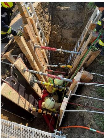
Dabei wurde unter realitätsnahen Bedingungen das Sichern von Künettenwänden, das Errichten von Zugangswegen und die Bedeutung klarer Kommunikation geübt.
