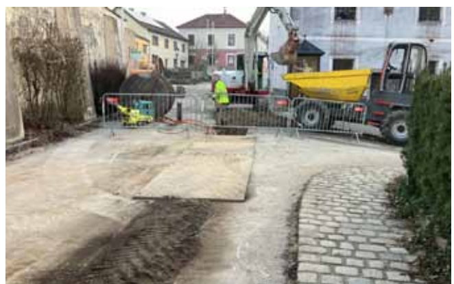
Foto: Glasfaser-Baustelle in Ardagger Stift.
