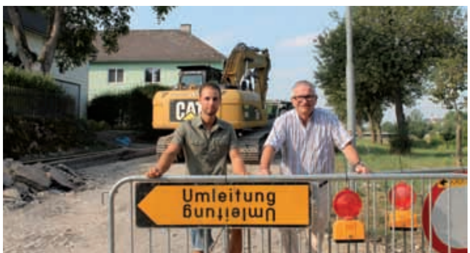
Bilder v.l.n.r.: Gf. GR Daniel Lachmayr und Bürgermeister Alfred Buchberger bei der Besichtigung der Baustellen (Erlenweg, Hopfenstraße und Ennsweg).
