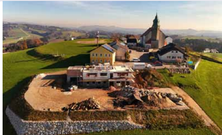
Foto: Baustelle Pfarrhof Kollmitzberg.
