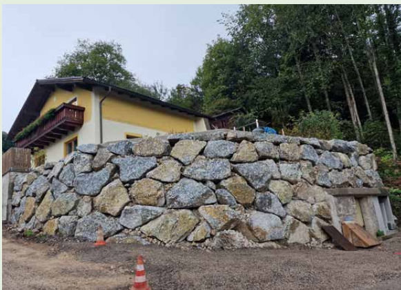
Steinmauer bei Drucksteigerungsanlage Salcherstraße
