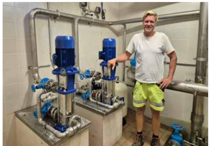
Vor kurzem wurden zwei neue Brunnenpumpen beim Hochbehälter in Grillenberg eingebaut.
