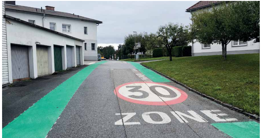
Die neuen Bodenmarkierungen sollen im Bereich der Voralpensiedlung die Fahrbahn optisch klarer leiten.
