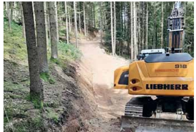
Foto: Sanierung des Forstweges von Tiefenbach in Richtung Innerzaun. © zVg
