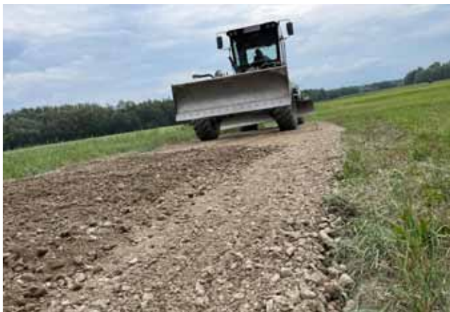
Foto: Sanierungsarbeiten nach dem Hochwasser: Die Wege in der Au werden mit Flinsmaterial angehoben. © zVg
