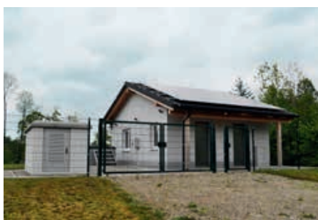
Bestes Trinkwasser bezieht die Marktgemeinde aus der Wasserversorgungsanlage Doislau.
