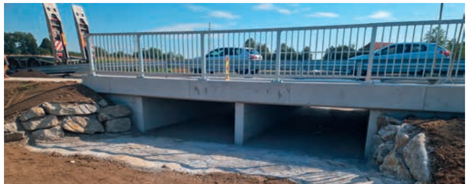
Das neue Durchlassbauwerk gewährleistet den ordnungsgemäßen Ablauf des Regenwassers.
