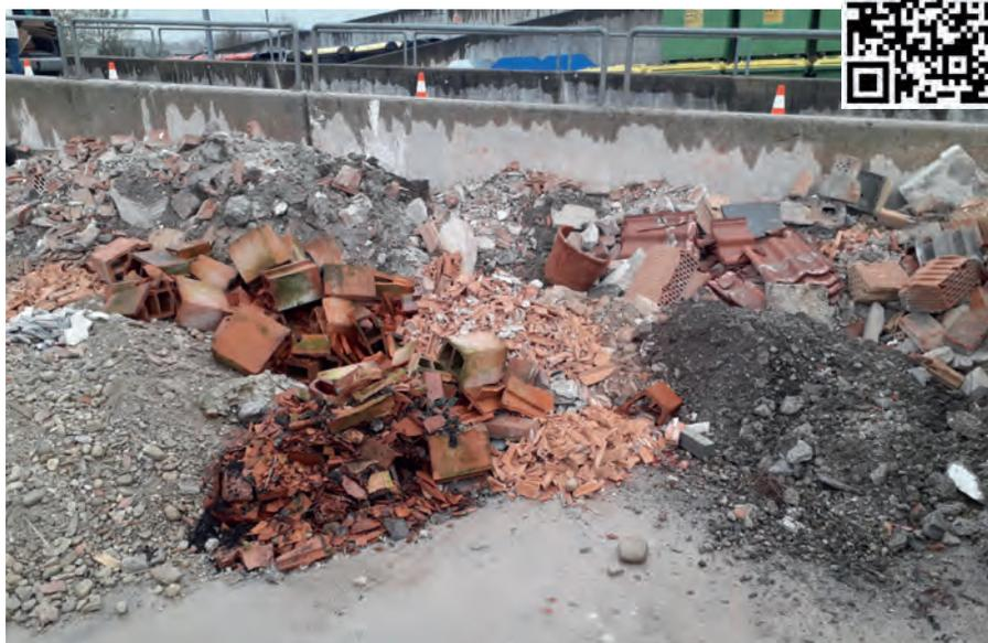
Recyclingfähiger Bauschutt wird zu recycelten mineralischen Hochbau-Restmassen weiterverarbeitet sowie für Künettenverfüllungen, Hinterfüllungen und Schüttungen verwendet.
