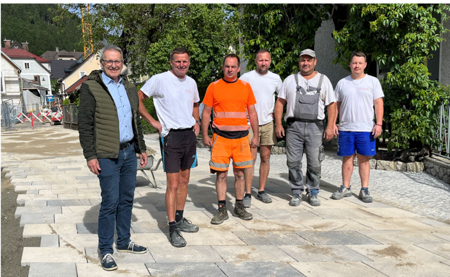
Bgm. Josef Schachner überzeugt sich vom Baufortschritt und bespricht mit Bauaufsicht Andreas Leichtfried und den Mitarbeitern der Lunzer Firma Frühwirth den weiteren Bauablauf.
