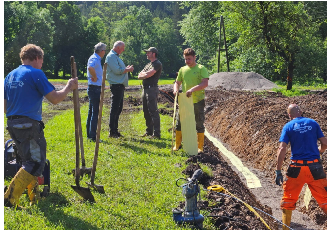
Erfreulicherweise ist der Glasfaserausbau in unserem Gemeindegebiet Lunz am See schon sehr weit fortgeschritten. Schon knapp 900 Lunzer Haushalte und Betriebe konnten angeschlossen werden.
