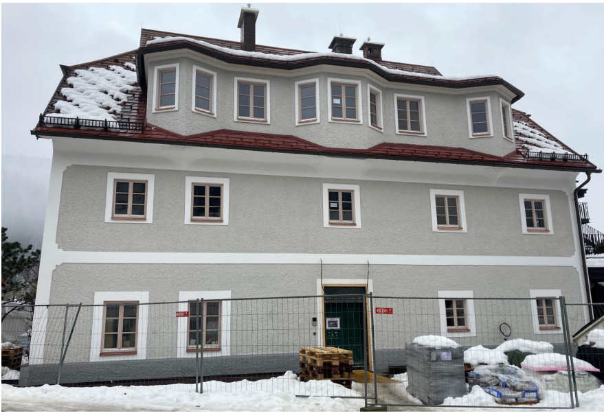
Die Bauarbeiten beim Refugium Lunz am Kirchenplatz gehen in die Endphase.
