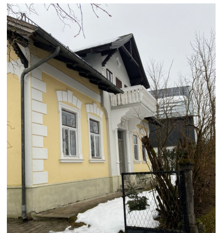
Liebvolle Renovierung bei der Villa in der Ybbsstraße 7
