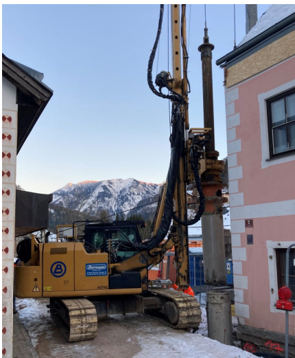
Beim Haus Ybbsstraße 2 entsteht mit großem Aufwand ein Um- und Zubau.
