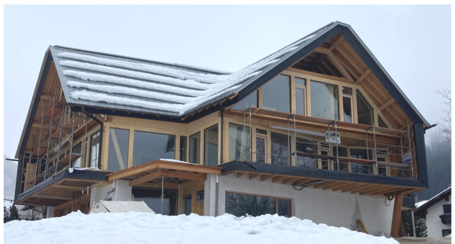
Das ehemalige Schuh- und Sportgeschäft wird zu einer Frühstückspension umgebaut.
