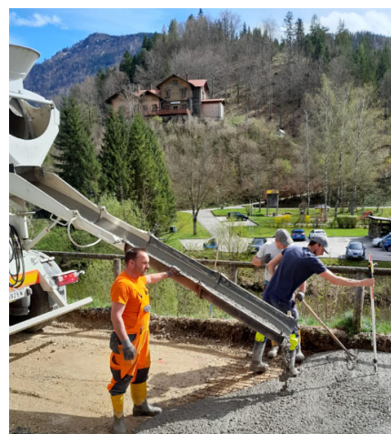
Aufgrund der Bodenbeschaffenheit wird unter der Fahrbahn eine Stahlbetonschicht eingebaut.
