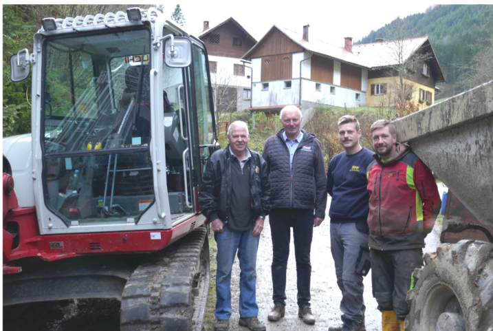
Vzbgm. Johann Strohmayer freut sich über den Baufortschritt bei der Glasfaserverlegung Sulzbach und dankt den Mitarbeitern der Firma Wurzer.
