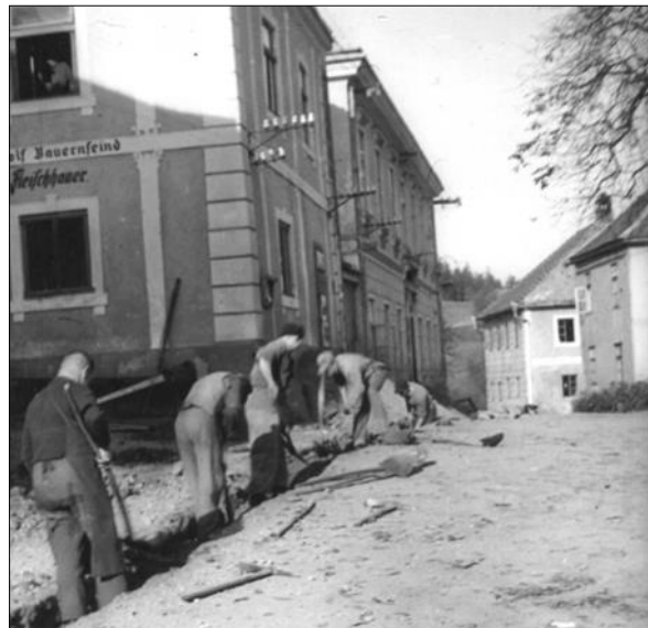
1954 Ortswasserleitungsbau vor der Fleischhauerei Bauernfeind
