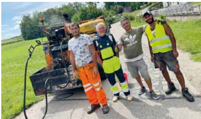
Foto: Das Team der Fa. Bit-Team, die die "Vergussarbeiten" in der Gemeinde erledigten.
