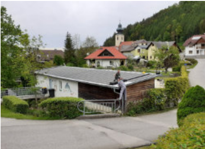
Gemeindegänger Johann Höhl Müller mit einem Mitarbeiter der Fa. Ast bei der Montage der Solaranlage
