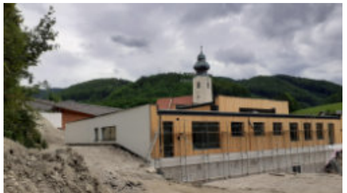
Die neue Lärchenholzfassade des Kindergartens wurde fertiggestellt.
