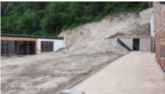
Der Spielplatz des neuen Kindergartens wird gerade angelegt.
