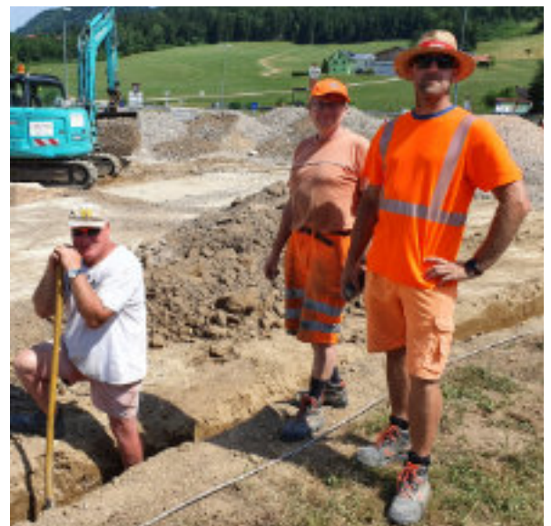
Bei hochsommerlichen Temperaturen arbeiten Peter Brandstetter, Karl Baumann und Toni Prüller fleißig an der neuen Park & Ride Anlage.
