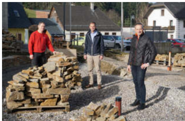
Gemeindegärtner Johann Frühwald, Vzbgm. Christian Vogelauer und Bgm. Franz Faschingleitner begutachten die Fortschritte beim Verlegen der Natursteinmauern am Dorfplatz.
