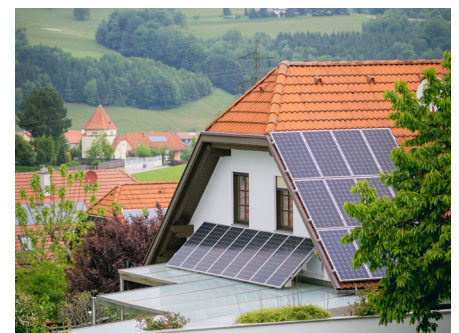
Die Wedsiedlung in Sonntagberg macht's vor: PV-Anlagen am Eigenheim
