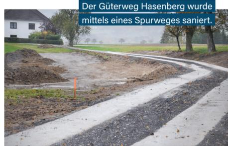
Der Güterweg Hasenberg wurde mittels eines Spurweges saniert.
