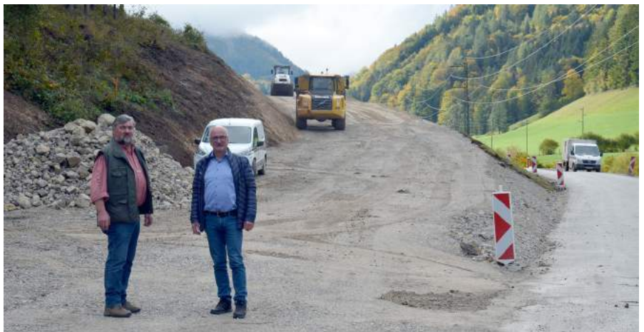
gGR Herbert Fahrnberger und Bgm. Gerhard Lueger besichtigten den Baufortschritt in der Prolling © Marktgemeinde Ybbsitz
