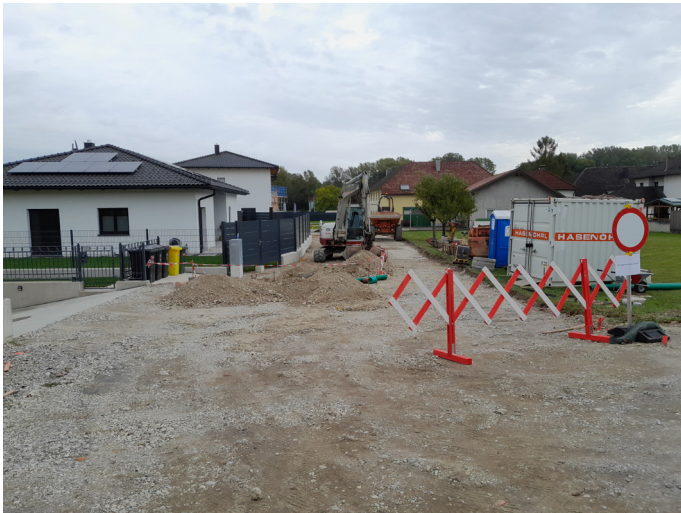
Straßenbauarbeiten im Dorfweg
