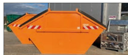
Orange Deckelmulden stehen für Dämmstoffe und Asbestzement bereit.
