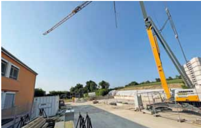
Foto: Die Baustelle Nahwärme ist bereits voll in Gang. © zVg
