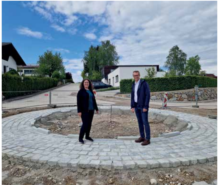
Ortsvorsteherin Julia Krifter und Bürgermeister Johannes Heuras begutachteten die Errichtung des neuen Kreisverkehrs im Bereich Obersteigerstraße/Girardistrafße. Ende Mai wurde hier ein Baum gepflanzt.
