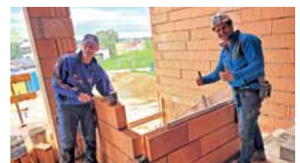
O: Kommandant und Verwalter-Stellvertreter beim Mauern der Zwischenwände.
