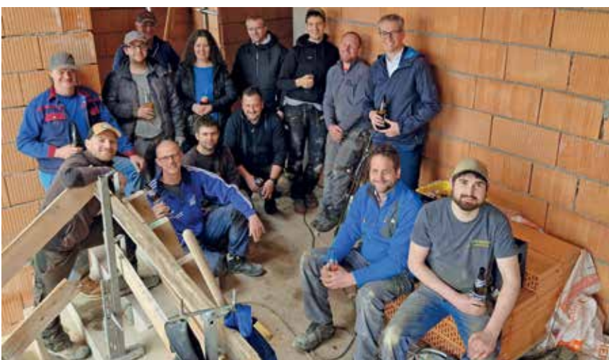
Bürgermeister Johannes Heuras, Feuerwehrreferent OV Johannes Tanzer und OV Julia Krifter besuchten die Baustelle und brachten ein paar Erfrischungen für die fleißigen Helfer mit.
