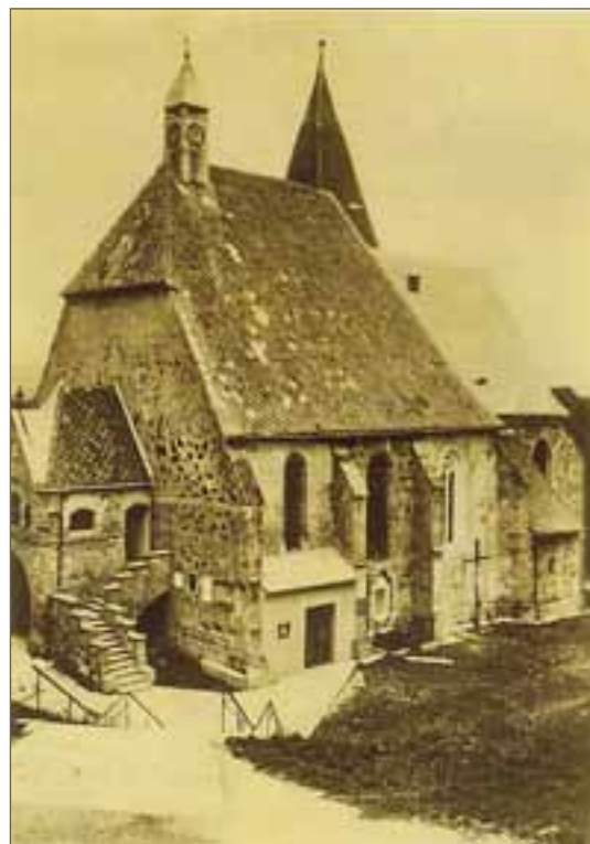
Die ehem. Kirche Stephanshart wurde in den 1960er-Jahren wegen Rutschung abgetragen.
