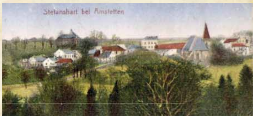
Diese Postkarte zeigt den Ort Stephanshart und die „ehemalige“ Kirche, die wegen Rutschung abgetragen werden musste.
