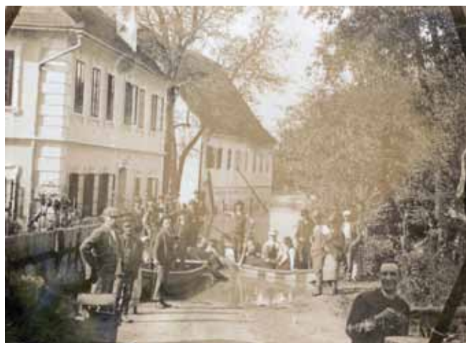
Foto: Hochwasser am 16.9.1899
