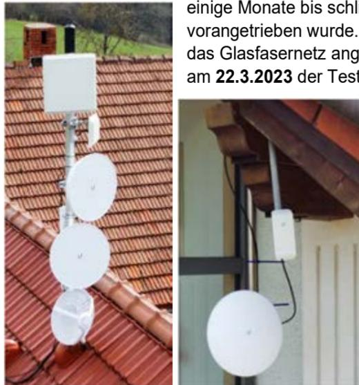
Bild 1: links Hauptsender, rechts Hausantenne (rund)
