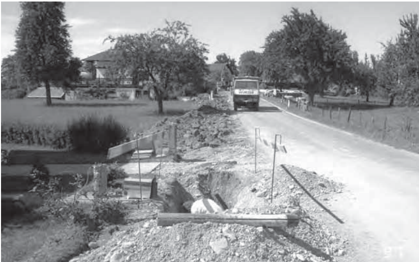
Foto links vom 29. Juli 1997: Baustelle Kanalbau in Schnotzendorf
