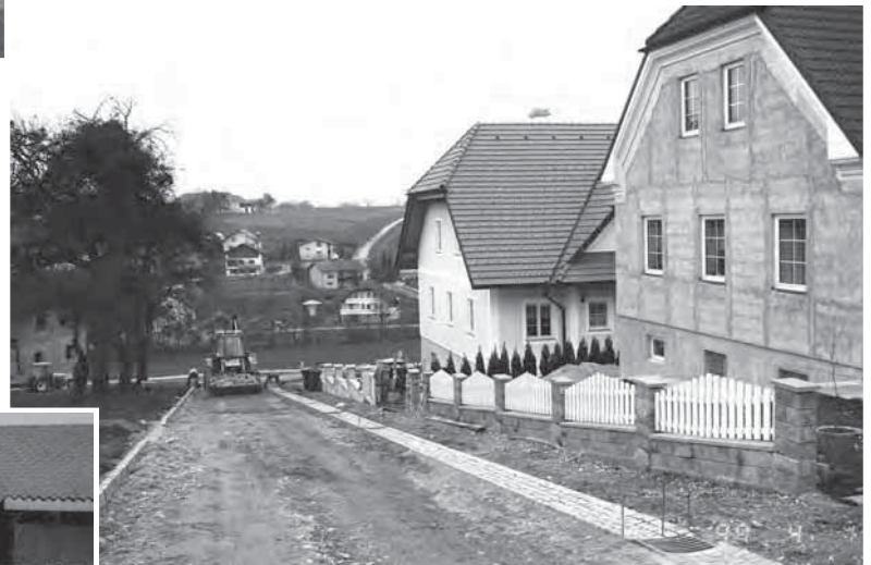
Rechts: Straßenbauarbeiten am Birkenweg. Foto vom 1. April 1997
