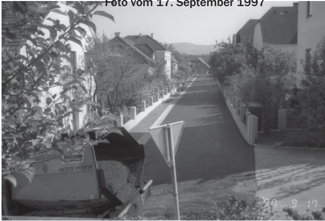
Brunnengasse fertig asphaltiert Foto vom 17. September 1997
