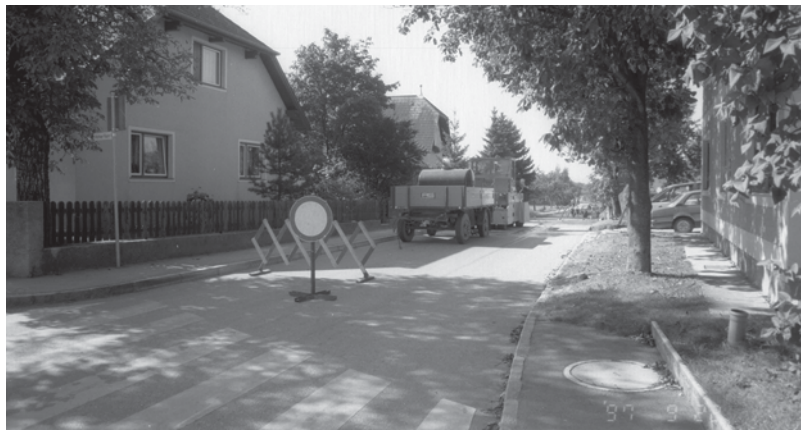
Wiederherstellungsarbeiten nach den Grabarbeiten in der Römerstraße am 22. September 1997
