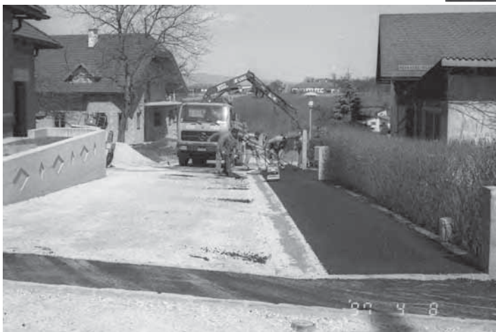
Birkenweg Asphaltierarbeiten am 8. April 1997
