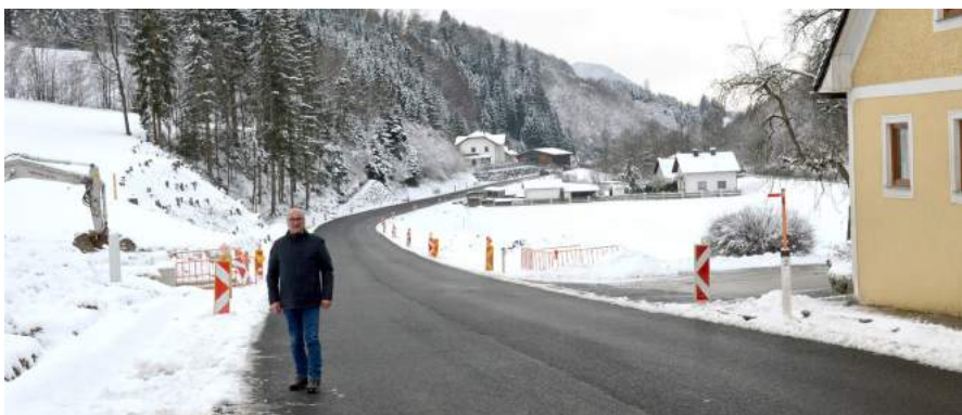
Die seit Sommer andauernden Bauarbeiten und die damit verbundenen Verkehrsbehinderungen können nun doch vor Weihnachten vorerst abgeschlossen werden. Anfang Dezember wurden die Asphaltierungsarbeiten durchgeführt und es konnten wieder beide Fahrspuren für den Verkehr freigegeben werden. Die endgültige Fertigstellung der Ausbauarbeiten erfolgt im Frühjahr 2023. © Marktgemeinde Ybbsitz
