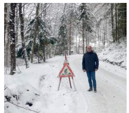
Auch am Güterweg Gaisberg wurde in den letzten Monaten im Bereich Anbindung an B22 bis Haus Klein-Bach intensiv gearbeitet. Der Unterbau wurde erneuert und die Entwässerungen neu ausgeführt. Gleichzeitig wurde auf einem Teilstück das Glasfaserkabel mitverlegt. Die Asphaltierungsarbeiten und weitere Abschlussarbeiten sind witterungsbedingt für das Frühjahr vorgesehen. © Marktgemeinde Ybbsitz
