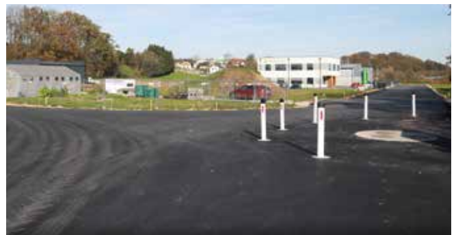
Asphaltierung - Betriebsgebiet Süd
