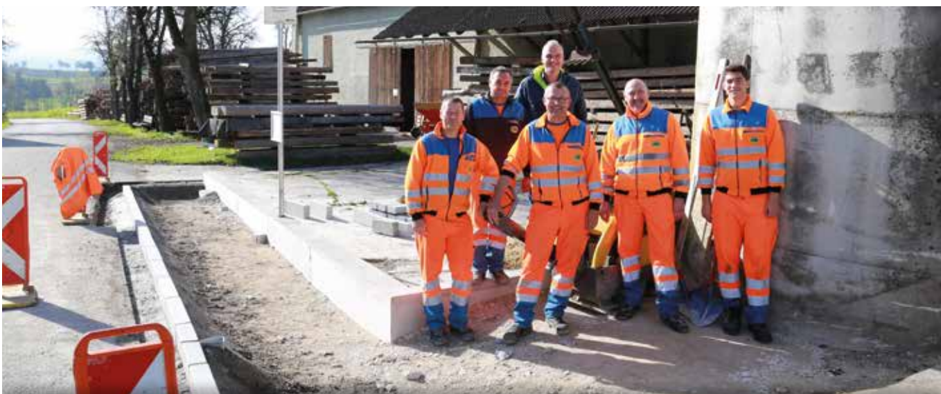
Errichtung der Bushaltestelle in Besendorf durch die Straßenmeisterei Amstetten Nord
