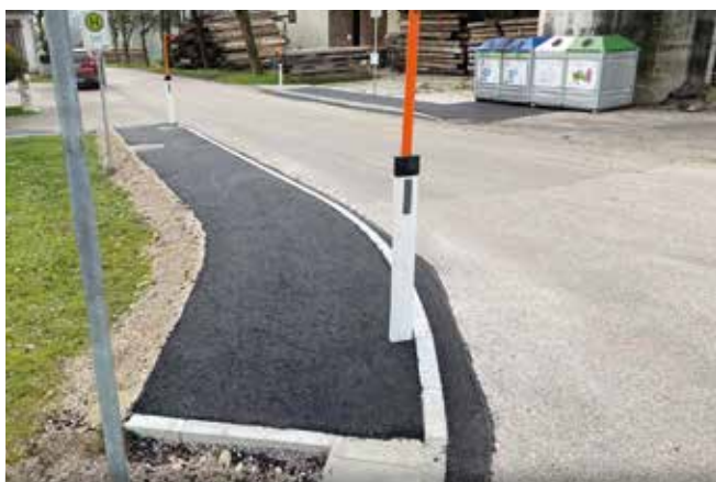
Errichtung Bushaltestelle Besendorf
