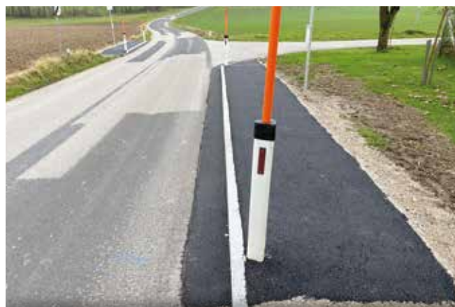
Errichtung Bushaltestelle Hötzing
