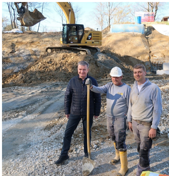
Foto Baubeginn: Ressortverantwortlicher gGR Ing. Karl Wadsak (li) überzeugte sich vom Baufortschritt des neuen Trinkwasserhochbehälters
