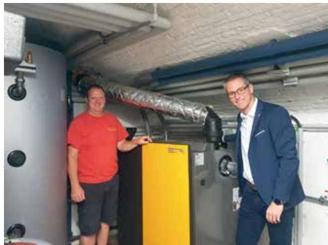
Bürgermeister Johannes Heuras und Installateur Richard Mayr bei der Inbetriebnahme der neuen Pelletsheizung in der Volksschule Kürnberg.
