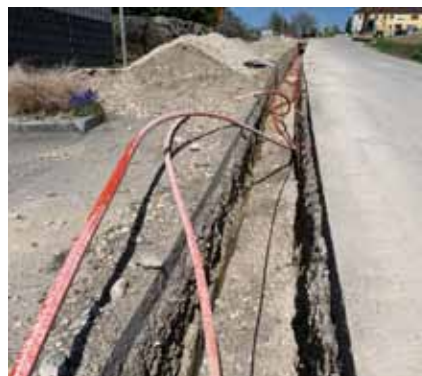
Foto: Glasfaserausbau in Kirchfeld. © zVg
