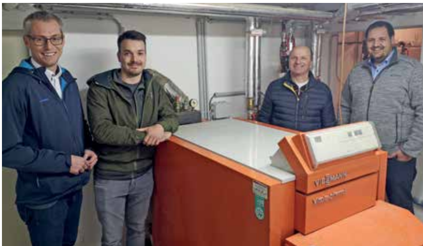
Die alten Ölkessel in Kürnberg und St. Michael werden durch klimafreundliche Pellets-Anlagen ausgetauscht. Darüber freuen sich, v.l. Bürgermeister Johannes Heuras, Planer GR Matthias Mayer, Ortsvorsteher Josef Streißberger und Umweltgemeinderat Andreas Gruber. Foto: GR Michael Pfaffenbichler
