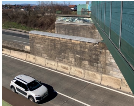
Foto: Die bestehenden Brückenpfeiler der Westbahnstrecke über die Autobahn könnten für eine Radwegbrücke zwischen Ennsdorf und St. Valentin genutzt werden. Planungen hierfür werden nun in Auftrag gegeben.
