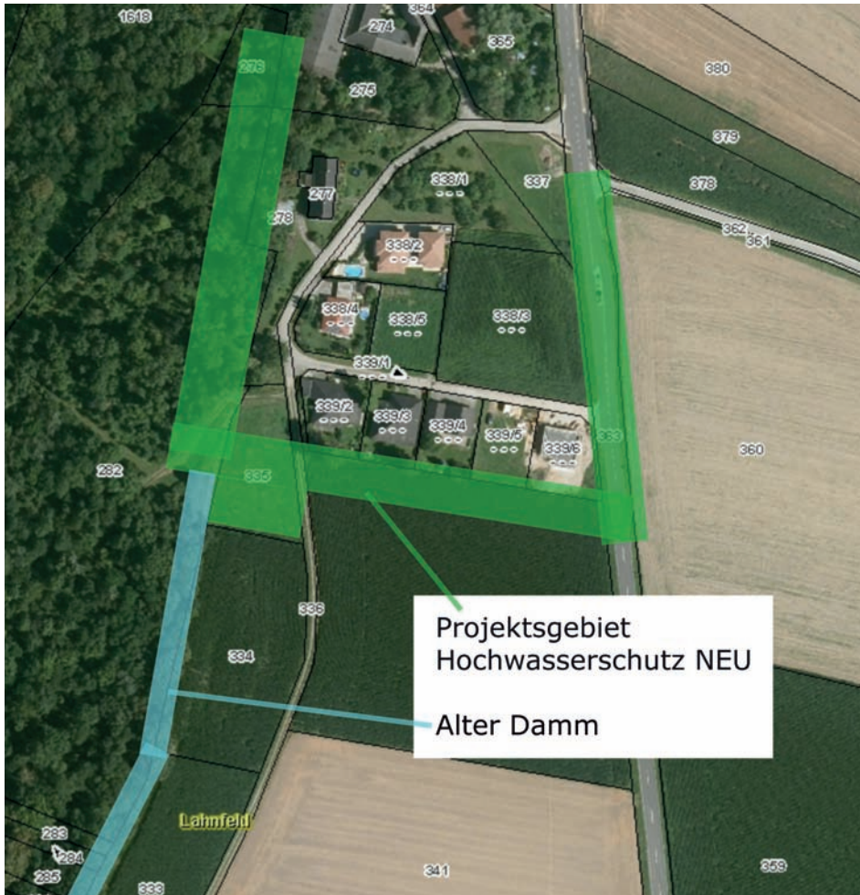
Das neue Schutzbauwerk soll Überflutungen der bewohnten Gebiete in Ennsdorf verhindern.
