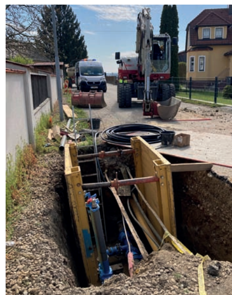
Sanierungsarbeiten in der Raaderstraße.
