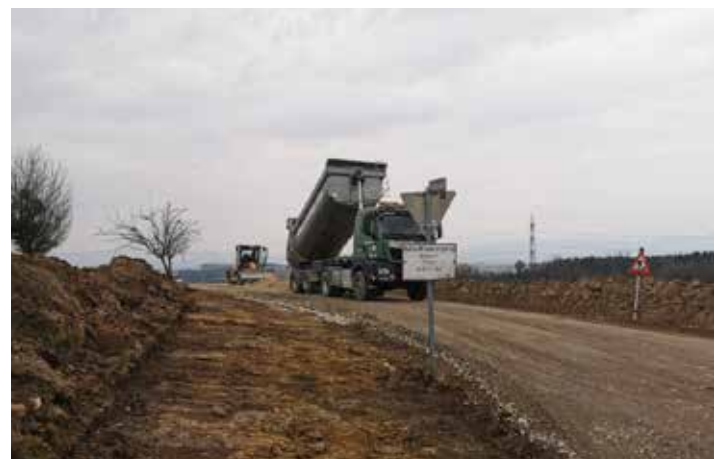
Fertigstellung des Unterbaus des Güterweges „Großhumpfl“
