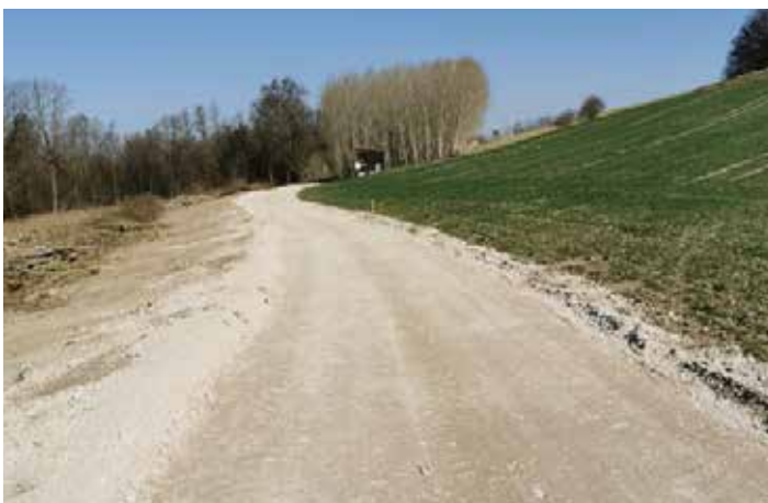
Fertigstellung des Unterbaus der Zufahrt zu den Wasserbrunnen in Hinterberg
