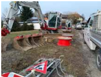
Foto: Glasfaserausbau in Ardagger. © zVg
