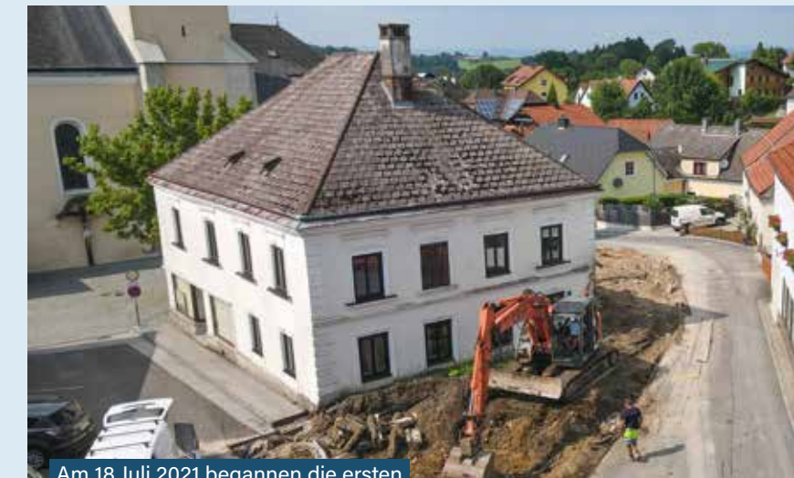
Am 18. Juli 2021 begannen die ersten Vorbereitungen für den Abriss
