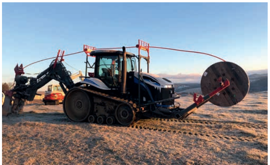
Die Firma Schönhofer Bau GmbH startete mitte Oktober mit den Bohrungsarbeiten
