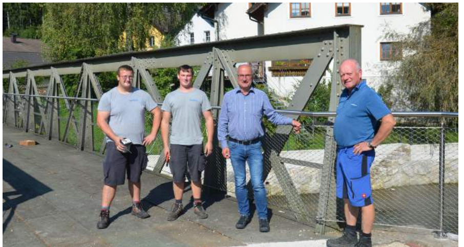
Mitarbeiter Fa. Metallprofis Hinterleitner, Bgm. Gerhard Lueger, Bauhofleiter Roman Teufel © Marktgemeinde Ybbsitz
