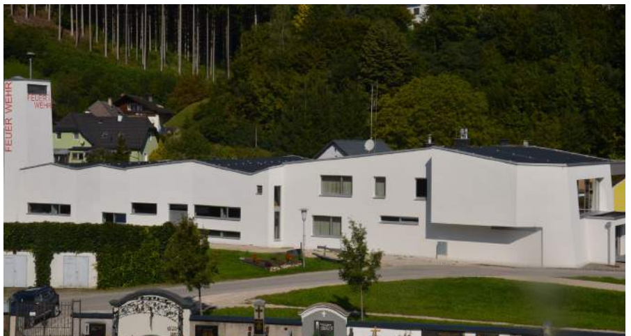
Fassadenerneuerung und Dachsanierung beim Feuerwehrhaus ist abgeschlossen. © Marktgemeinde Ybbsitz
