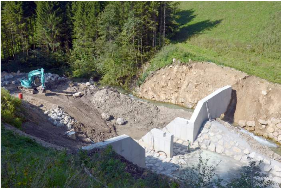
Baustelle der Gchiebesperre im Bereich Einödhammer © Marktgemeinde Ybbsitz
