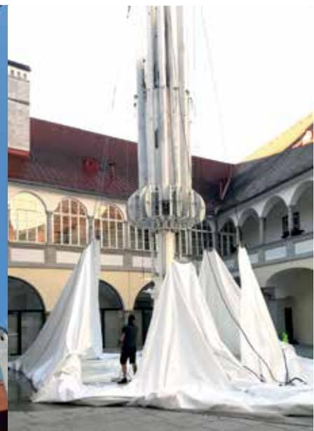
Mit zwei Mini-Kränen und zwei Hebebühnen wurde die neue Schirmmembrane montiert.
