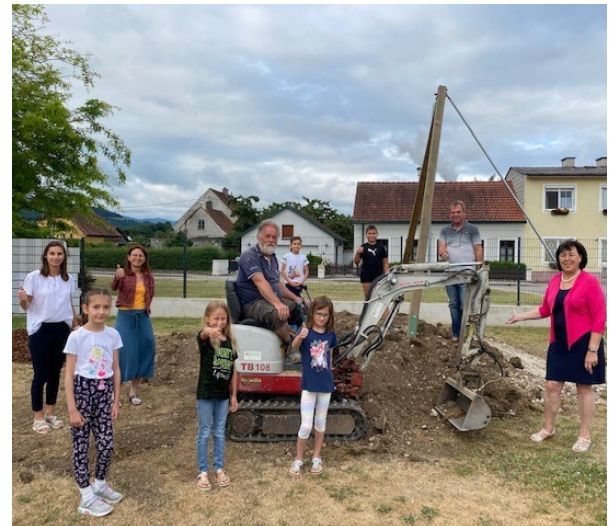
Foto: Bgm. Juliana Günther und Sport- und Freizeitreferent gGR Gerwald Schattleitner (re) überzeugten sich von der fachgerechten Ausführung der Bauarbeiten
